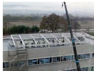
写真13. 本館空調設備更新工事
