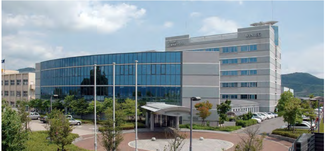
写真1. 工業技術センター外観
