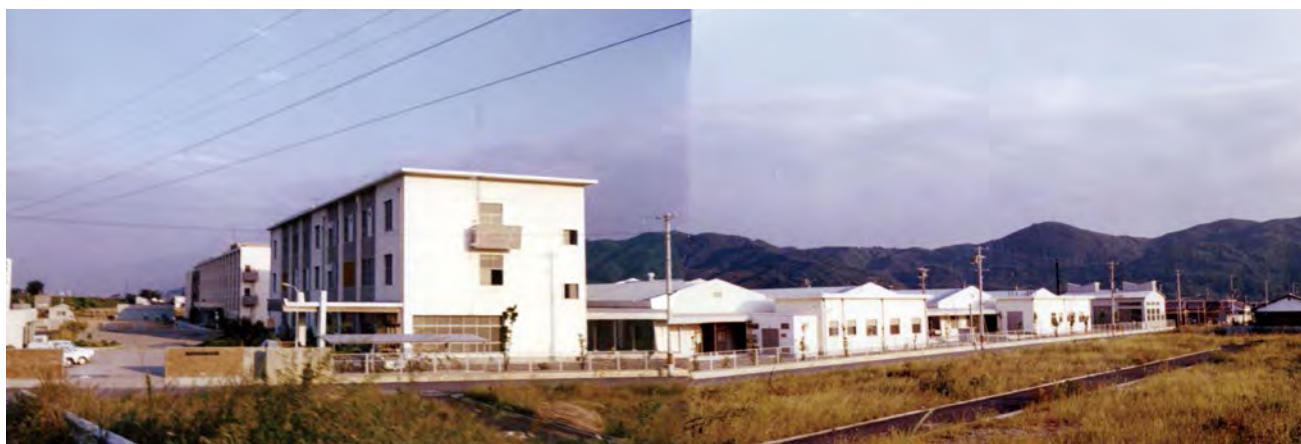
写真6 完成したころの工業試験場全景（当時の写真を使って合成したパノラマ写真）
