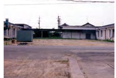
写真 3. B 棟を撤去した跡地
