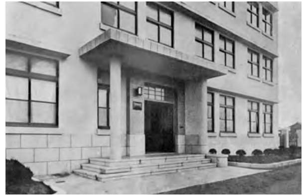
写真 2. 本館正面玄関（竣工当時）
