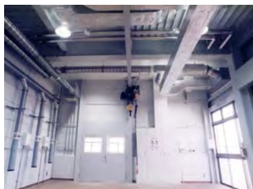
写真9. 実証棟（金属加工室）
