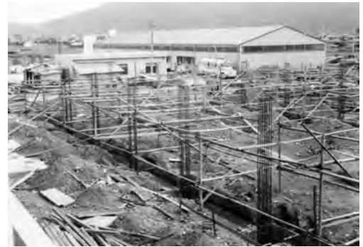
写真3 建設中の工場棟（昭和41～42年ごろ） 向こうに見えるのは県公共職業訓練所
