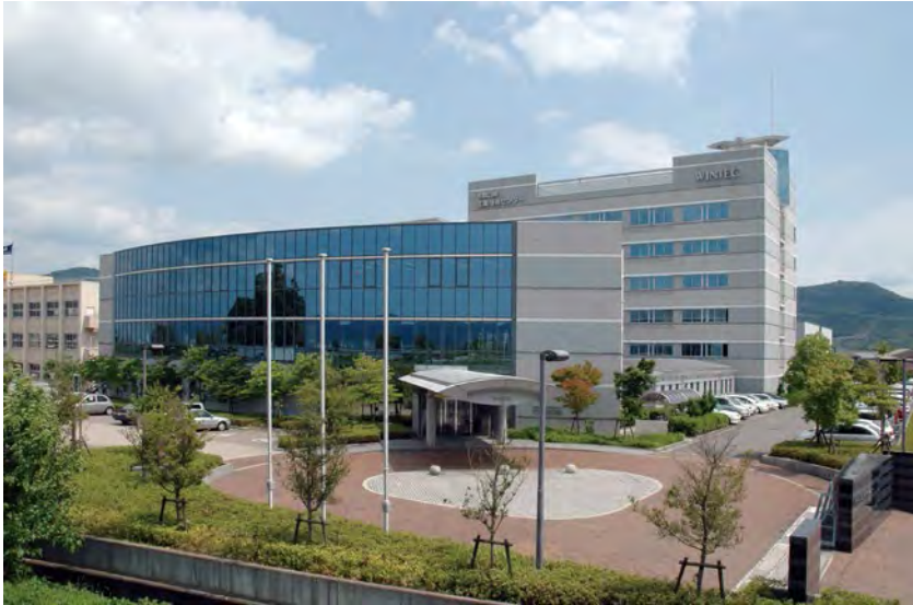
写真1. 現在の庁舎（平成8年度に完成）
