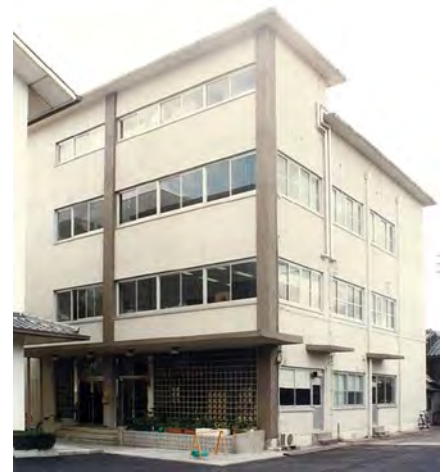
写真2 漆器試験場外観 (H9.3)
