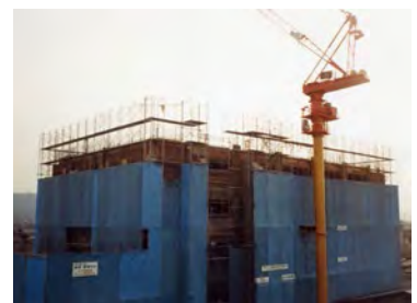
写真 4. 建築中の研究交流棟
