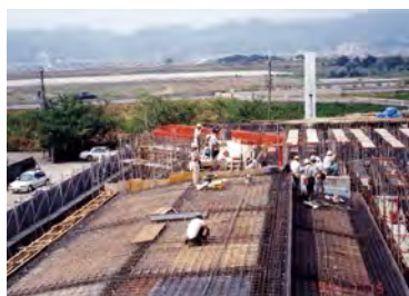
写真8. 新本館建築工事
