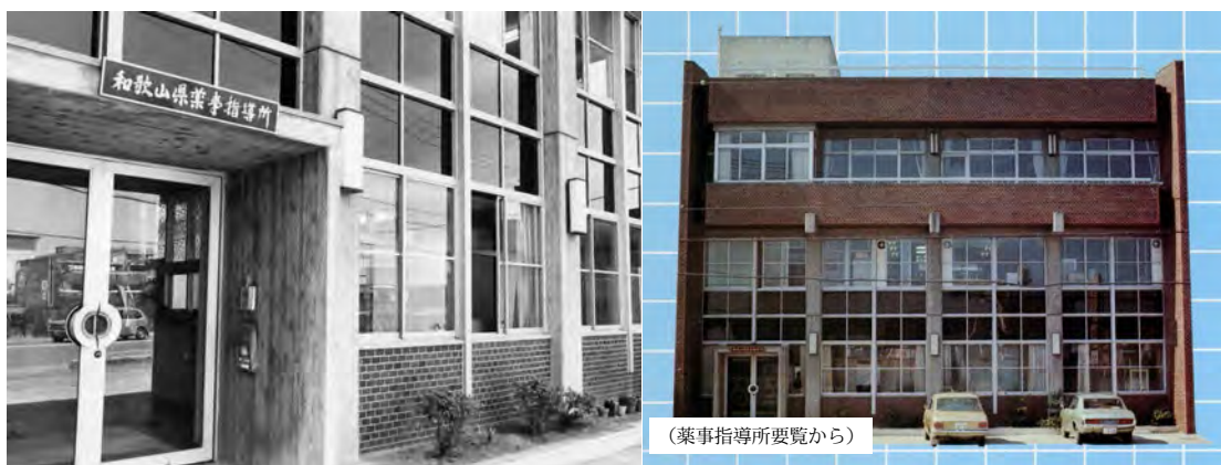
写真1. 和歌山市湊の庁舎正面
