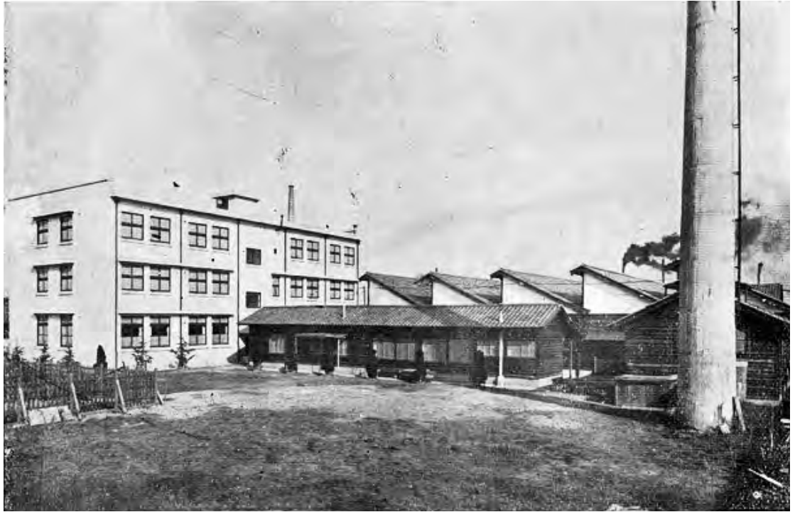
写真1. 竣工時の工業試験場（宇須）敷地南西角から北東方向を写す
