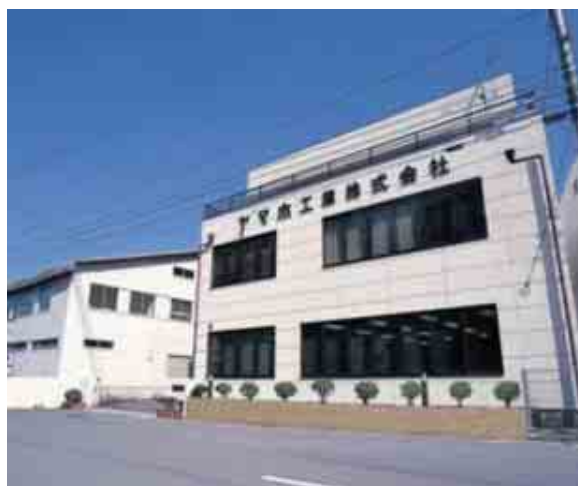
本社工場（日高郡日高川町）
