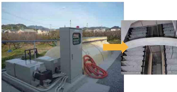
図3 小規模排水処理装置
