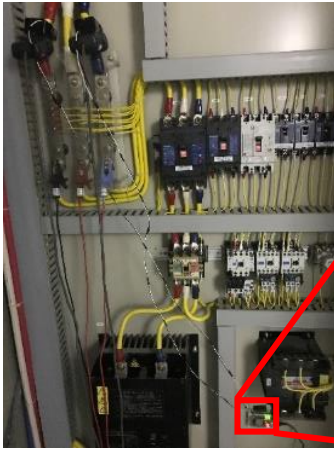
分電盤に取り付けた 電流測定モジュール
