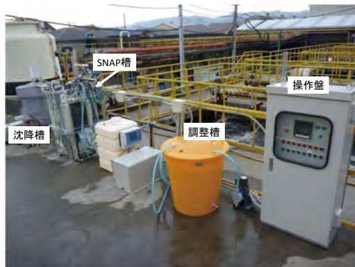
図 14. 一槽型アナモックス処理プラント（捺染染色業・A 社に設置）
