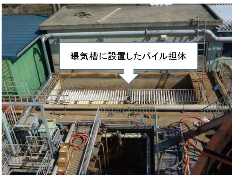
図 23. みなべ町 B 社の排水処理設備へのパイル単体の設置
