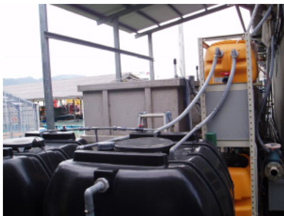
パイロットプラント
